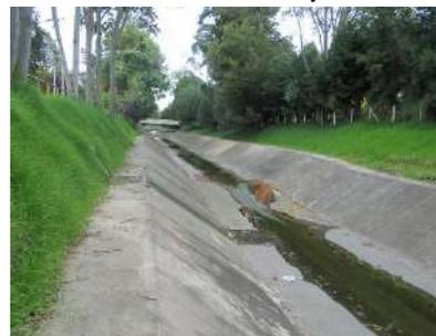
**Fotografía 7.** Se evidencia sobre el margen izquierdo el vertimiento de un colector de la Red Local Pluvial de una tubería en concreto reforzado ubicada en la dirección TV 73-24C 2 de coordenadas 4°39'54.50"N y 74° 7'1.49"O.
