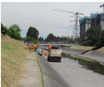
**Fotografía 34:** Se evidencia proceso de desarrollo urbano sobre el margen norte del canal a la altura de la 72c y 72d los cuales están realizando intervención en la estructura del canal para la instalación de una red hídrica
