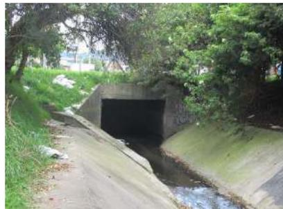
**Fotografía 3.** Estructura trapezoidal en concreto del canal Boyaca aguas debajo de su ingreso en la localidad de Fontibon.
