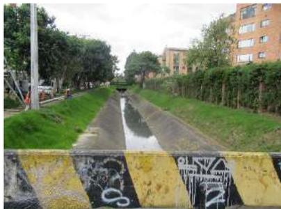
Fotografía 10. Entrega de las aguas al Box Culver que atraviesa la Av. Calle 24 y continua su flujo por el canal Oriental
