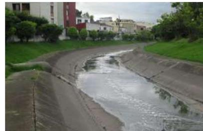
**Fotografía 19.** Vertimiento sobre el margen izquierdo del canal por parte de una Estructura de Red Pluvial ubicada en la AV 86-23ABIS 67, con diametro de tubería 32" en concreto sin Refuerzo, en las coordenadas 04°40'.12,82"N y 74°07'40.15"W.
