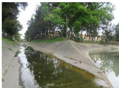
**Fotografía 20.** Confluencia del canal Boyaca con el canal San Francisco, el flujo de agua denota características de agua residual doméstica en virtud de las espumas y olores ofensivos perceptibles a la distancia, situación que se presenta por la existencia de conexiones erradas aguas arriba.
