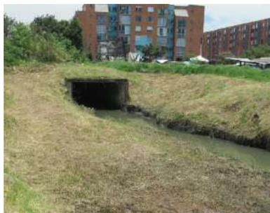
**Fotografía 20.** Canal Hayuelos aguas arriba de su desembocadura en la estructura de concreto tipo Box Culvert que desemboca en el canal San Antonio.
