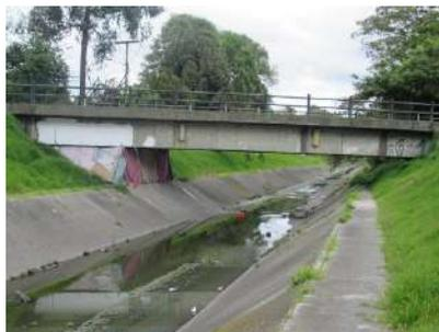
**Fotografía 16.** Se evidencia sobre el margen izquierdo el vertimiento de una estructura de entrega de la Red Local Pluvial de una tubería en concreto ubicada en la TV 73A-23 82 de coordenadas 4°39'44.66"N y 74° 7'19.11"O.
