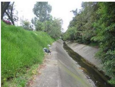
**Fotografía 4.** Estructura trapezoidal en concreto del canal Boyaca aguas debajo de su ingreso en la localidad de Fontibon
