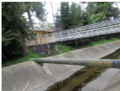
**Fotografía 6.** Estructura trapezoidal en concreto del canal Boyaca aguas abajo de la Calle 24D-BIS. Se evidencia sobre el margen izquierdo el vertimiento de un colector de la Red Troncal Pluvial de una tubería de 20" de diametro de PVC, en las coordenadas 4°39'55.33"N y 74° 6'58.72"O.
