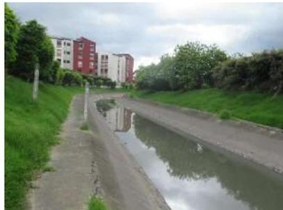
**Fotografía 18.** Vertimiento sobre el margen izquierdo del canal por parte de una Estructura de Red Pluvial ubicada en la AV 86-23ABIS 67, con diametro de tuberia 32" en concreto sin Refuerzo.
