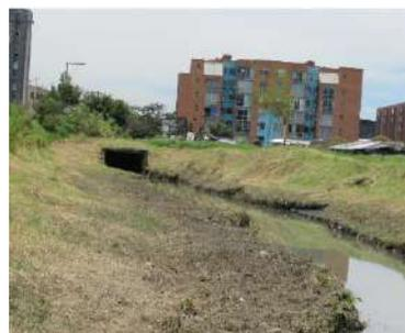
**Fotografía 19.** Canal Hayuelos entrega de aguas a estructura de concreto tipo Box Culvert que desemboca en el canal San Antonio.
